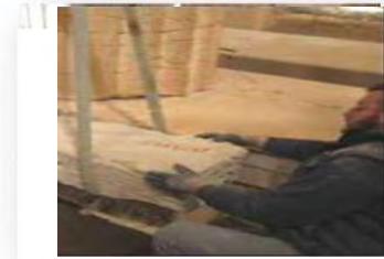
Πλήρωση ανασκαφικής τομής στο βόρειο πτερό με σταθεροποιημένη άργιλο και αργούς λίθους (11-4-2014) Filling of the archaeological cut at the Northern side stabilized clay and rough-hewn stones (11-4-2014)
