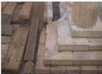
Επανατοποθέτηση δύο κρατευτών στο βόρειο πτερό (17-4-2014) Reposition the two steps on the north side (17-4-2014)
