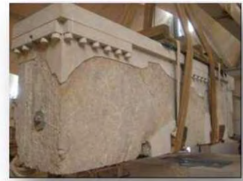
Επαναφορά στο μνημείο του 1 ου από Α. Επιστυλίου της βόρειας όψης (21-3-2014 και 2-4-2014) Repositioning of the 1 st Eastern epistyle of the Northern side (21-3-2014 and 2-4-2014)
