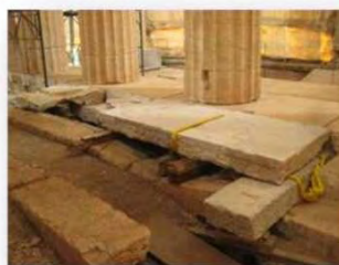
Δοκιμαστική αναστηση τεσσάρων πλακών οαλειού και ενός κρατευτή στο βόρειο πτερό (17-4-2014) Test restoration of four floor slates and a step on the north side (17-4-2014)
