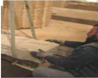
Τοποθέτηση φύλλου μολύβδου για στεγανοποίηση (16-4-2014) Lead sheet for waterproofing installation (16-4-2014)
