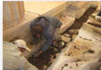
Πλήρωση ανασκαφικής τομής στο βόρειο πτερό με σταθεροποιημένη άργιλο και αργούς λίθους (11-4-2014) Filling of the archaeological cut at the Northern side stabilized clay and rough-hewn stones (11-4-2014)
