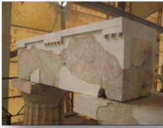
Επαναφορά στο μνημείο του 1 ου από Α. Επιστυλίου της βόρειας όψης (21-3-2014 και 2-4-2014) Repositioning of the 1 st Eastern epistyle of the Northern side (21-3-2014 and 2-4-2014)
