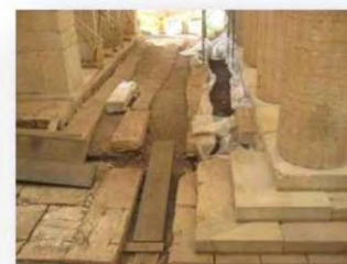
Δοκιμαστική αναστηση τεσσάρων πλακών οαλειού και ενός κρατευτή στο βόρειο πτερό (17-4-2014) Test restoration of four floor slates and a step on the north side (17-4-2014)
