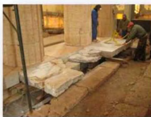
Δοκιμαστική αναστηση τεσσάρων πλακών οαλειού και ενός κρατευτή στο βόρειο πτερό (17-4-2014) Test restoration of four floor slates and a step on the north side (17-4-2014)
