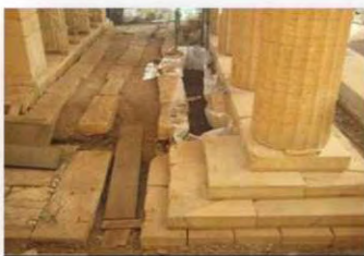
Πλήρωση ανασκαφικής τομής στο βόρειο πτερό με σταθεροποιημένη άργιλο και αργούς λίθους (11-4-2014) Filling of the archaeological cut at the Northern side stabilized clay and rough-hewn stones (11-4-2014)
