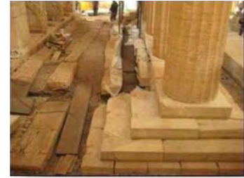
Τοποθέτηση φύλλου μολύβδου για στεγανοποίηση (16-4-2014) Lead sheet for waterproofing installation (16-4-2014)
