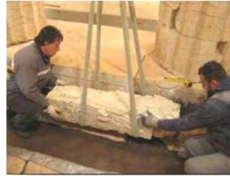
Τοποθέτηση φύλλου μολύβδου για στεγανοποίηση (16-4-2014) Lead sheet for waterproofing installation (16-4-2014)
