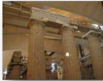
Επαναφορά στο μνημείο του 1 ου από Α. Επιστυλίου της βόρειας όψης (21-3-2014 και 2-4-2014) Repositioning of the 1 st Eastern epistyle of the Northern side (21-3-2014 and 2-4-2014)
