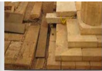
Επανατοποθέτηση δύο κρατευτών στο βόρειο πτερό (17-4-2014) Reposition the two steps on the north side (17-4-2014)
